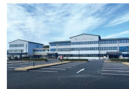
▲ 駐車場(300台駐車可能)
